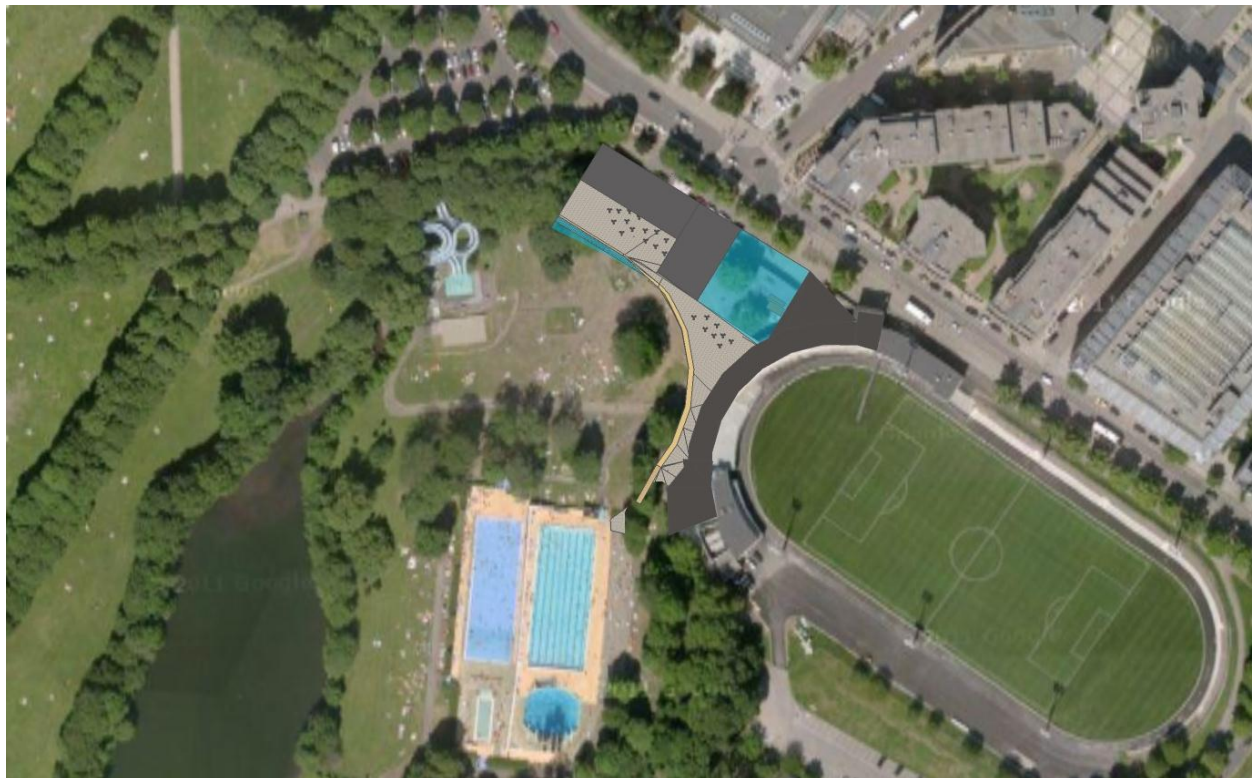
Figur 2 - Synlige deler av byggetrinn 1, 2 og 3
